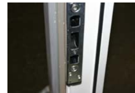
Foto 8 Schließleiste im Bereich Nebenverriegelung
