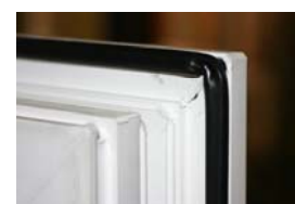
Foto 10 Detail Dichtungsstoß Flügel
