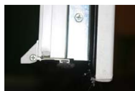
Foto 11 Detail Flügelichtung mit Bürstendichtung unten
