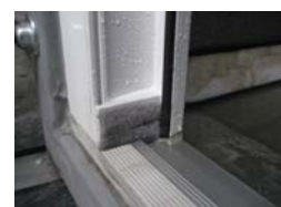
Foto 12 Detail Schwellenanschlag unten
